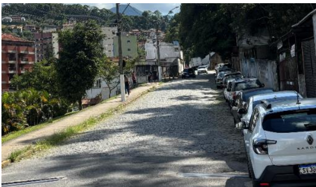
Figura 40: Pavimento com blocos intertravados de pedra natural
