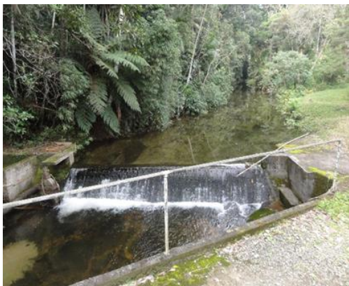
Figura 25 – Barragem Vargem Grande
