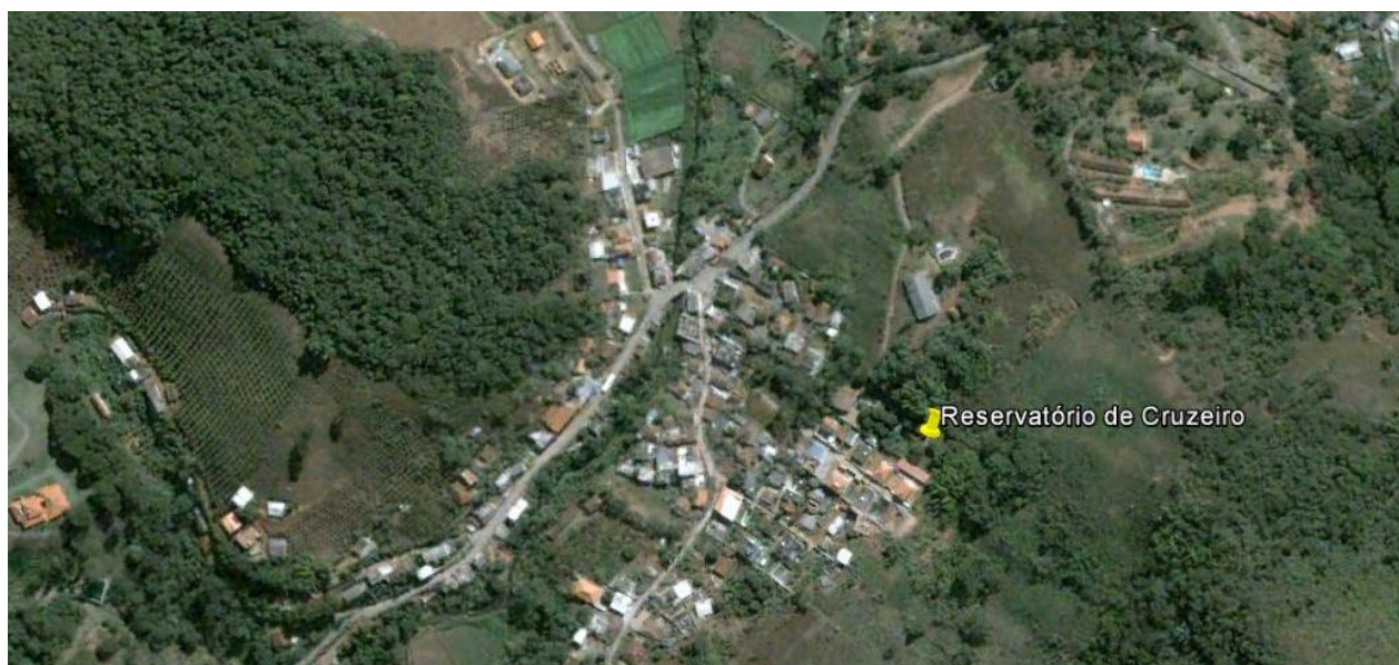
Figura 17 – Reservatório de Cruzeiro.
