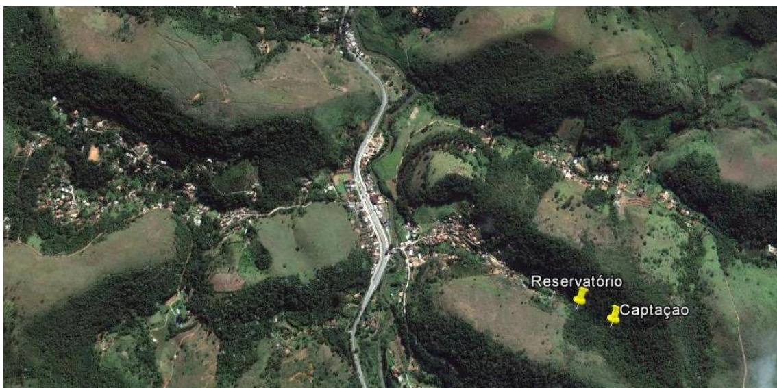
Figura 19 – Captação e reservatório de Pessegueiros.
