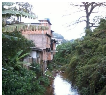
Figura 35 – Ponto de Lançamento-Esgoto 02.
