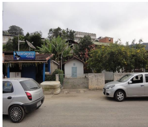
Figura 26 – Elevatória Vargem Grande.
