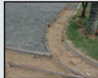
Nivelamento e compactação do subleito, colocação de brita, instalação de fôrmas e telas de aço.
