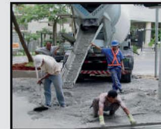
Lançamento, espalhamento e nivelamento (sarrafeamento) do concreto.
