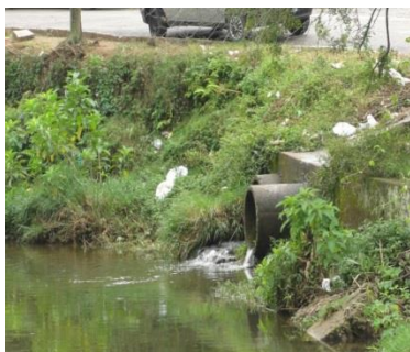
Figura 34 – Ponto de Lançamento-Esgoto 01.
