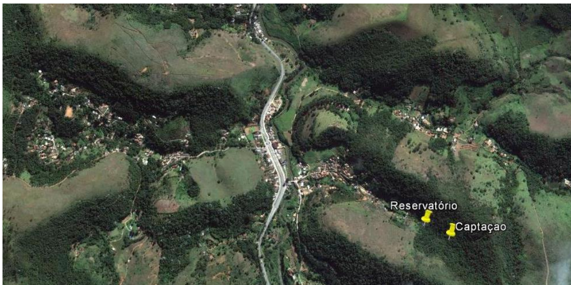
Figura 19 – Captação e reservatório de Pessegueiros.
